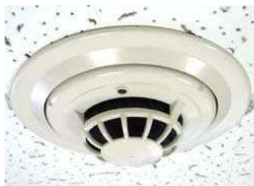
RMK400 с с комбинированным адресным извещателем ИП212/101-3А Leonardo-ОТ
