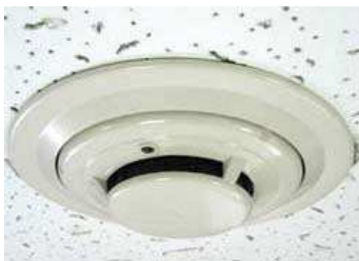
RMK400 с дымовым адресным извещателем ИП212-60А Leonardo-О
