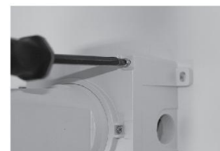
Затяните винты на монтажном корпусе
